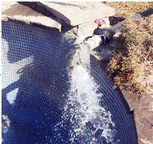
انتقال پساب به حوضچه جهت آبیاری درختان
